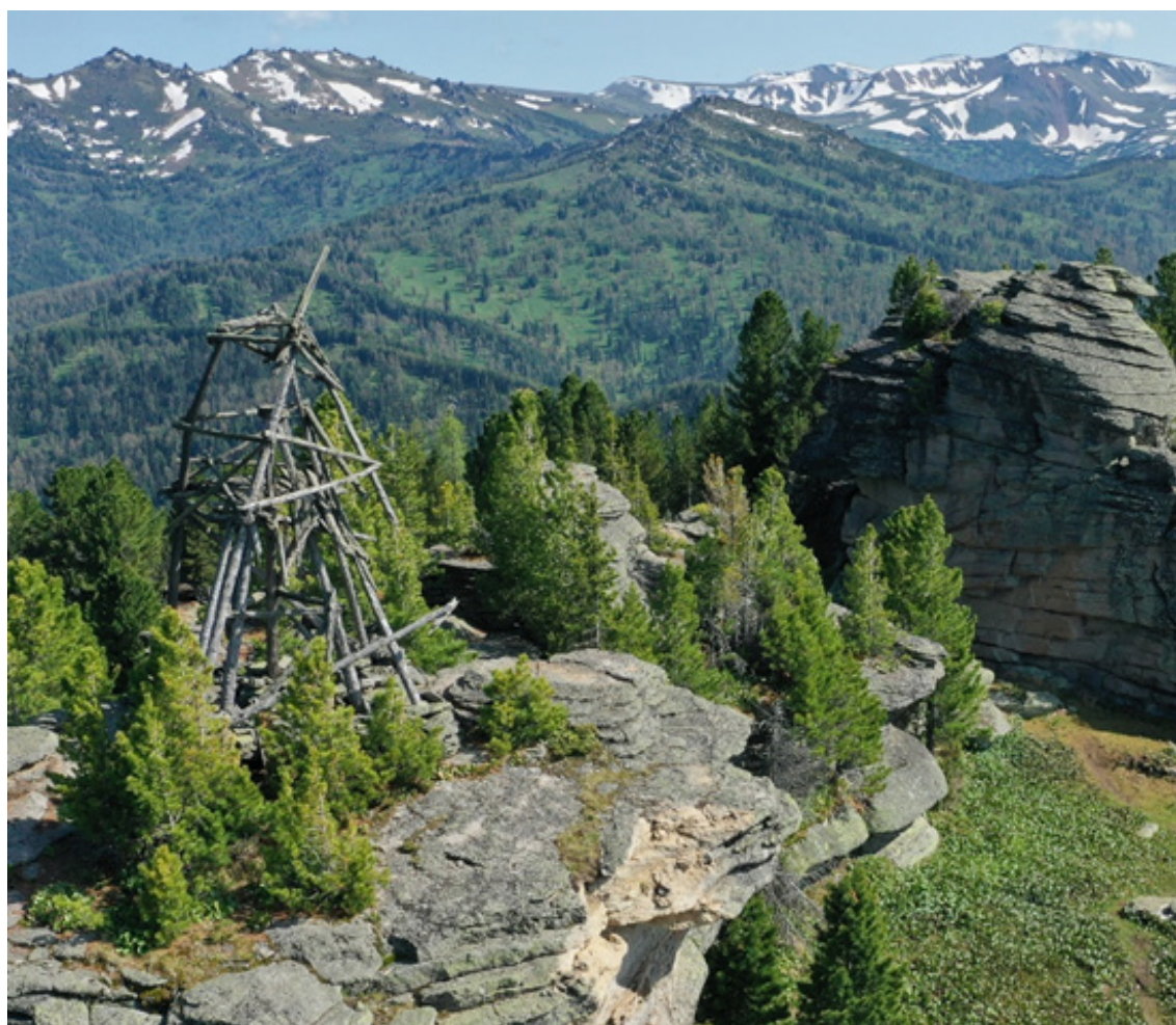
Рис 2. Триангуляционный пункт на вершине горы «Панорама»
